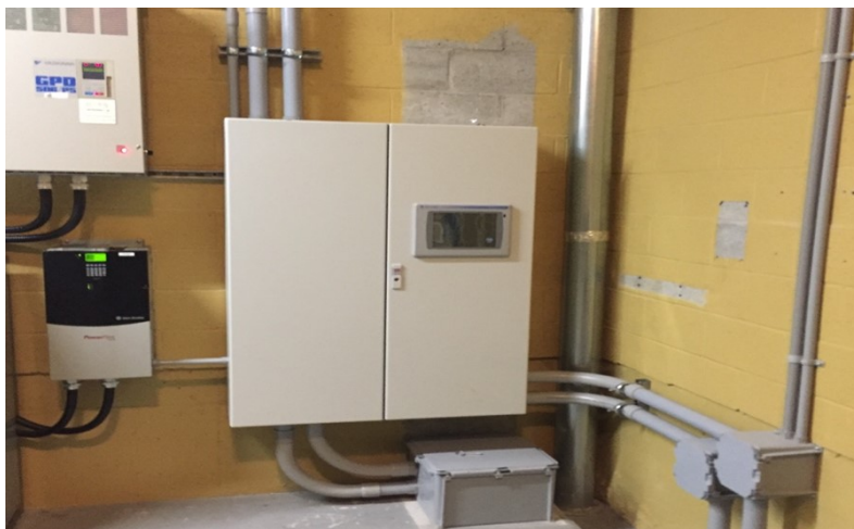
Remplacement du panneau de contrôle du réservoir Jackson
