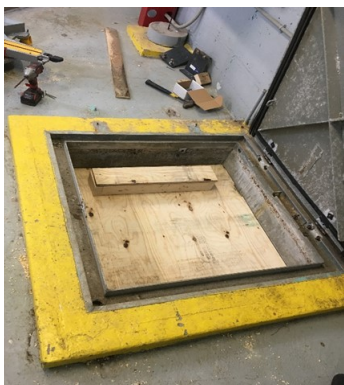
Remplacement des trappes d'accès au réservoir Sainte-Madeleine
