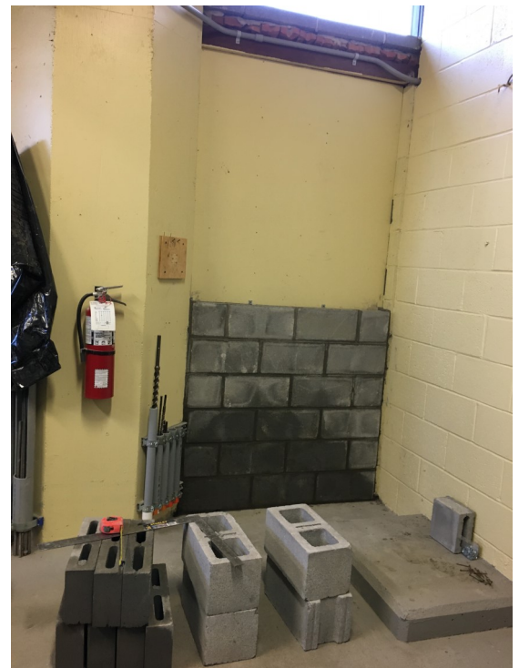
Travaux de maçonnerie—ancienne salle des génératrices
