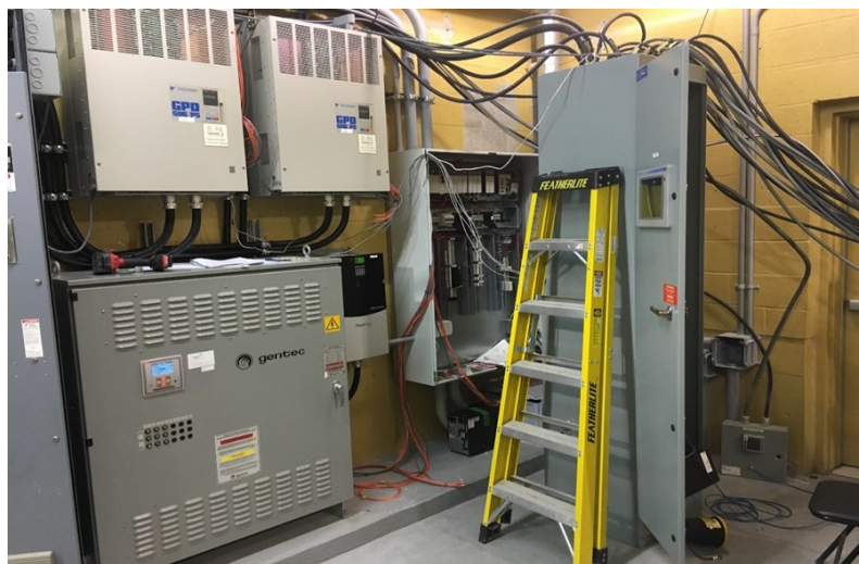
Remplacement du panneau de contrôle du réservoir Jackson
