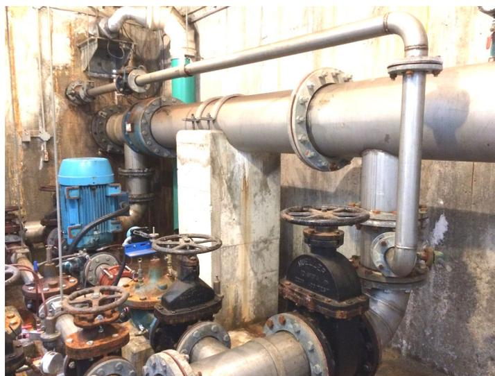
Remplacement d'une vanne de contrôle de pression au surpresseur Ozias-Leduc (avant [haut] et après [bas])
