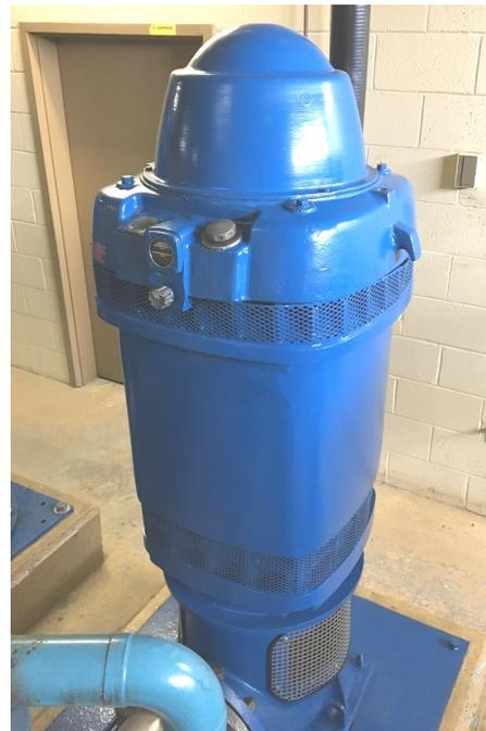
Réfection d'une pompe à turbine verticale, moteur de 250 HP
