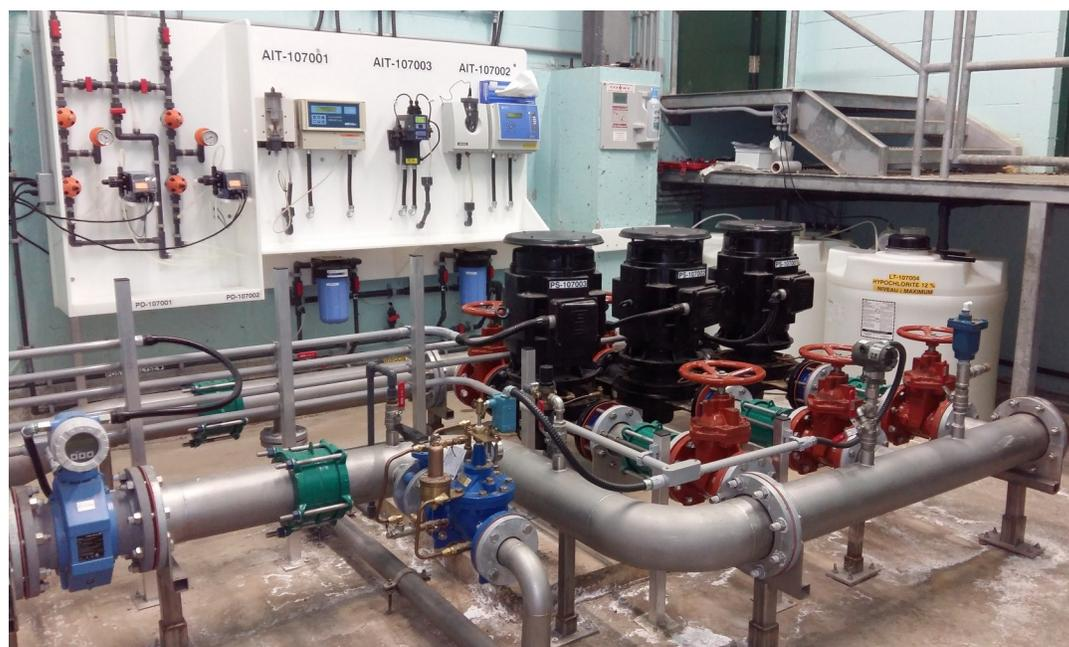
**Travaux de réfection du réservoir Saint-Jean-Baptiste : assemblage de pompes de surpression en avant-plan, pompes doseuses et analyseurs de chlore en arrière-plan**
